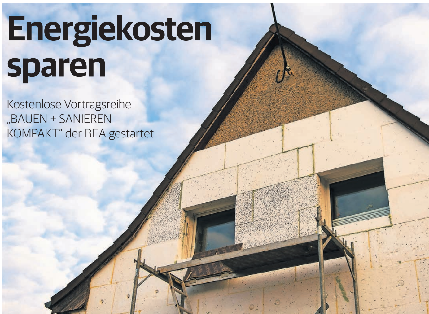
Das A und O ist eine gute Dämmung: Ein Haus aus den 1930er-Jahren wird mit Styroporplatten auf der Außenwand gedämmt.
