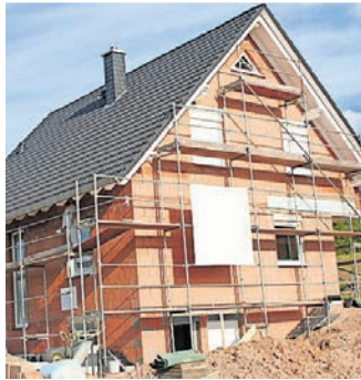
Vor dem Hausbau hat der Gesetzgeber die Grundstücksererschließung gesetzt.
