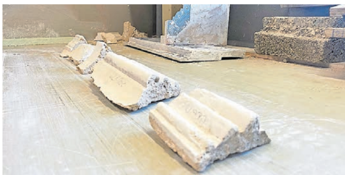
Von den Stuckleisten werden gut erhaltene Stücke ausgebaut, die anschließend verwendet werden, um eine Schablone aus Blech herzustellen.
