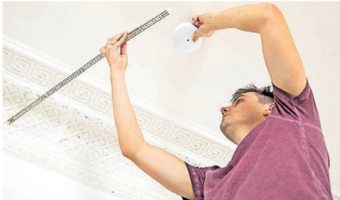
Damit der Rauchmelder richtig arbeiten kann, sollte auf genug Abstand zu Wänden und Möbeln geachtet werden. FOTO: CHRISTIN KLOSE/DPA
