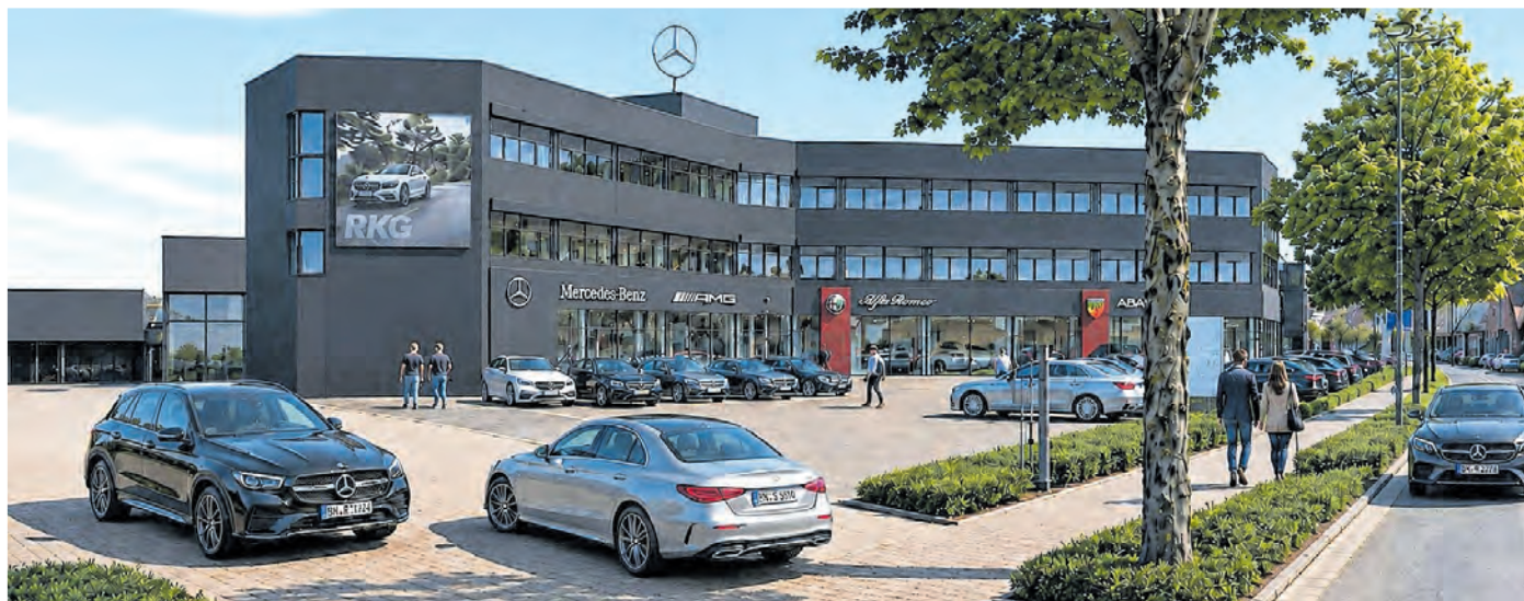
Am Hauptstandort der RKG gibt es alle Marken unter einem Dach, damit jeder das passende Fahrzeug findet.
