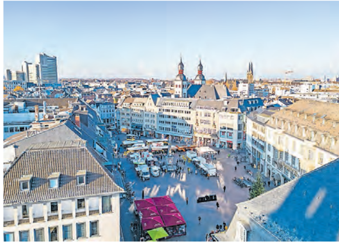
Ein Blick über die Bonner Innenstadt, die aktuell unter der Nordbrückensperre leidet.
