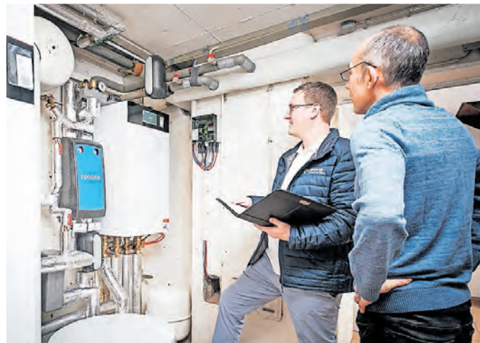
Berater Sebastian Breuer nimmt den Zustand der bestehenden Heizungstechnik auf.
