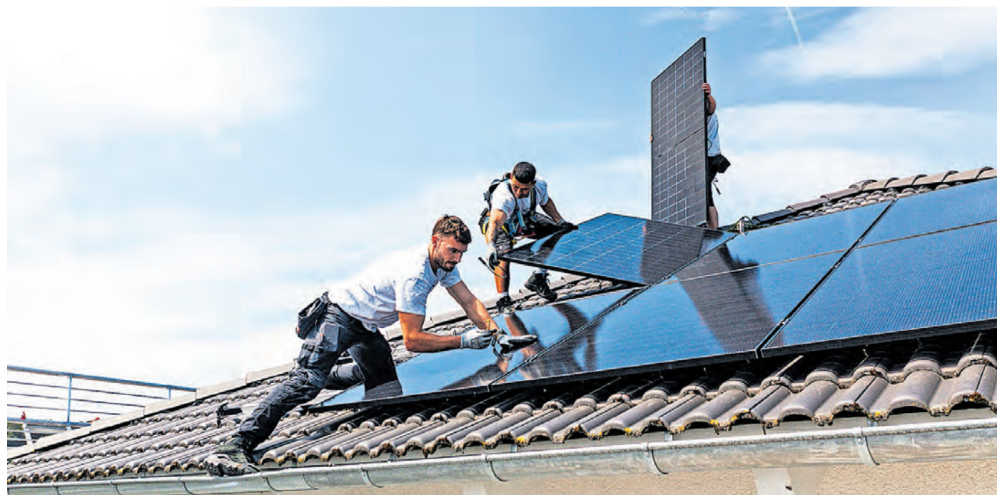
Bei EnergieGewinn packt der Chef (l.) auch selbst auf dem Dach mit an.
