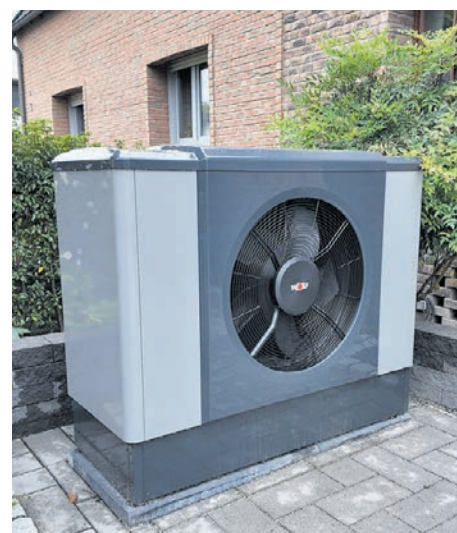
Eine Wärmepumpe gewinnt Wärme aus der Außenluft und wandelt sie in Heizenergie für das Haus um.
