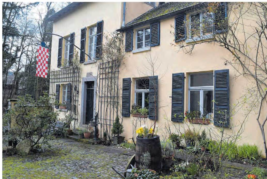
Haus Parzival in Menzenberg wurde von Karl Simrock 1840 errichtet und von Professor Helmut Arntz in den 1980er-Jahren vor dem Verfall gerettet.
