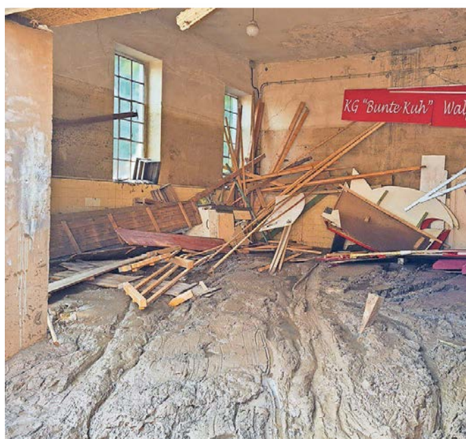
Ein Blick ins Alte Wasserwerk, der „Wagenhalle“, wo die Wagen während der Flut standen
