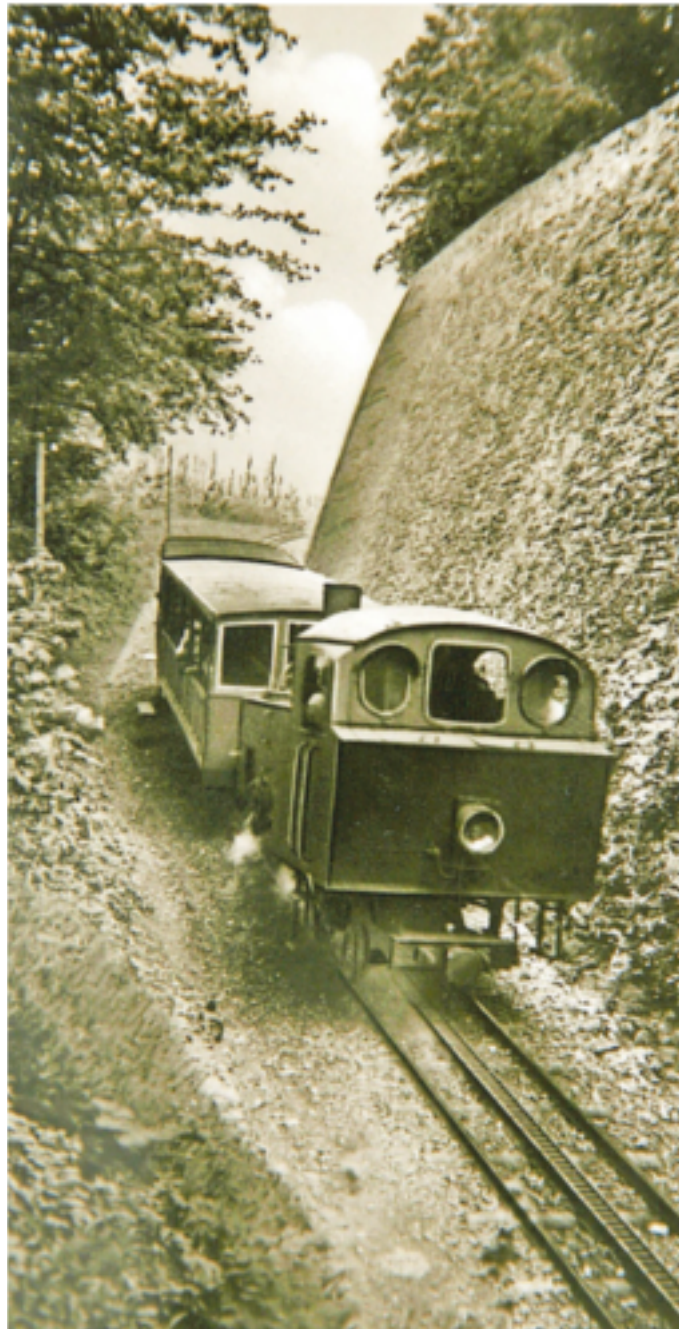
Eine historische Ansicht der Drachenfelsbahn – die Stützmauer steht seit der Errichtung der Bahn 1883. FOTOS: BERGBAHNEN SIEBENGEBIRGE
