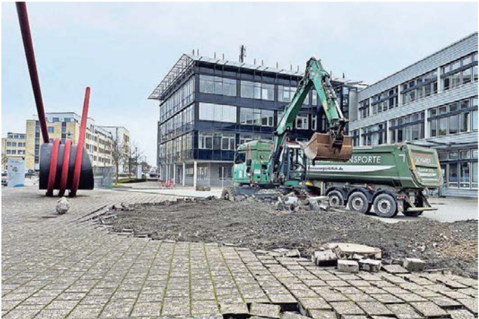
Rückblick: Im Februar 2024 hat die Umgestaltung mit dem Aufreißen der Pflasterung begonnen.
