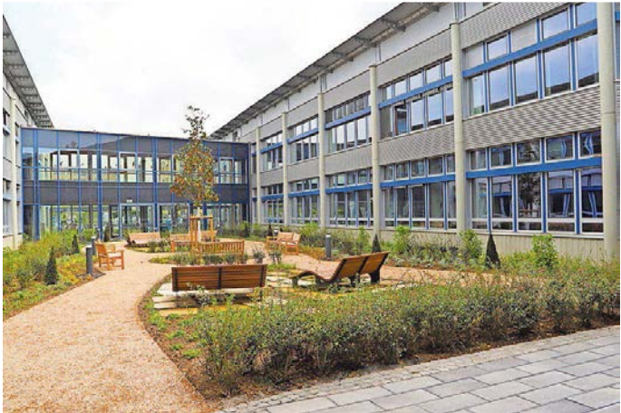
Für die kleine Pause zwischendurch: Der neu gestaltete Innenhof lädt zum Verweilen ein.
